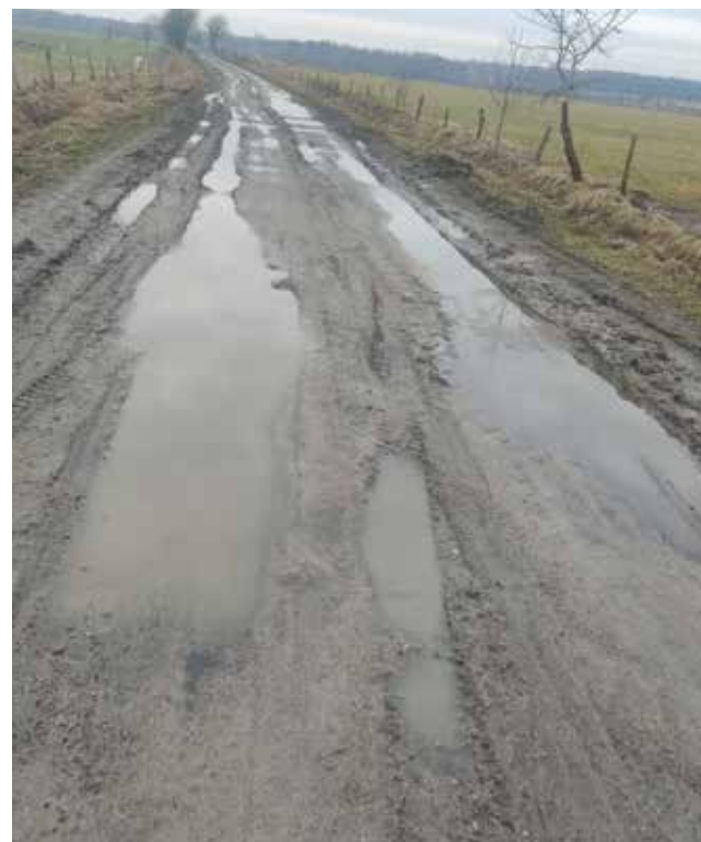
Droga w Starym Siedlisku – przed przebudową
