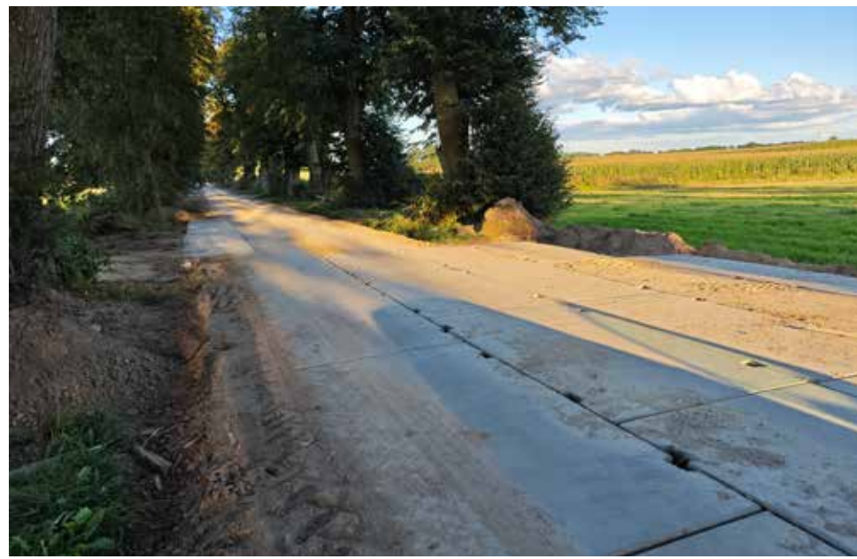
Droga w Ławkach – po wykonanych pracach
