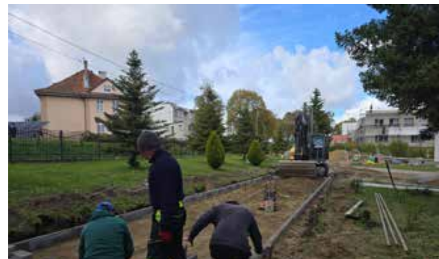
Trwa modernizacja ciągów pieszo-jezdnych przy MGOPS i ŚDS
