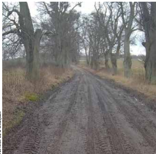
Droga w Ławkach – przed przebudową
