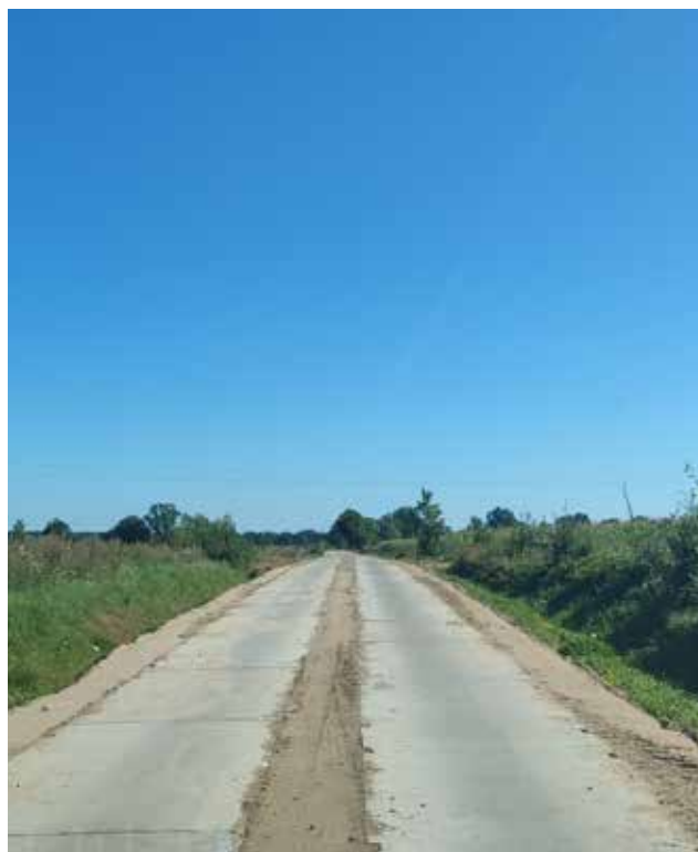
Droga w Starym Siedlisku – po przebudowie
